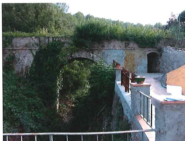
Pas elevat de l'aigua de la sèquia per lliurar el desnivell del Sot del Guix.
